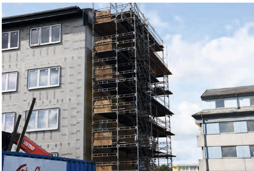
FIGUR 48. Igangværende renovering i efteråret 2019.
