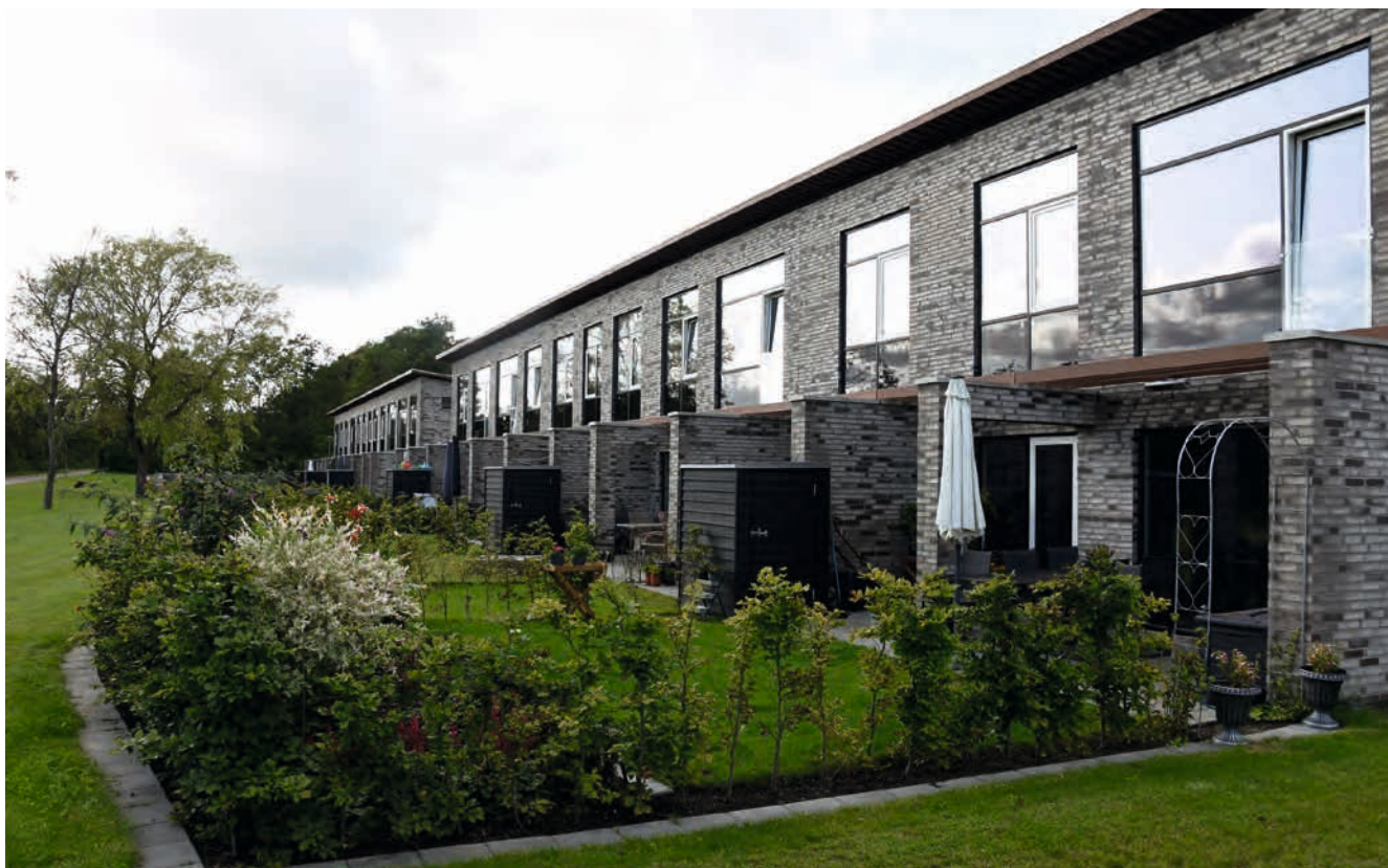
FIGUR 26. Frueløkkens nye rækkehuse er opført oven på soklerne fra en tidligere boligblok. Bygningskroppen er delt op i to ved at lave en passage i midten.
