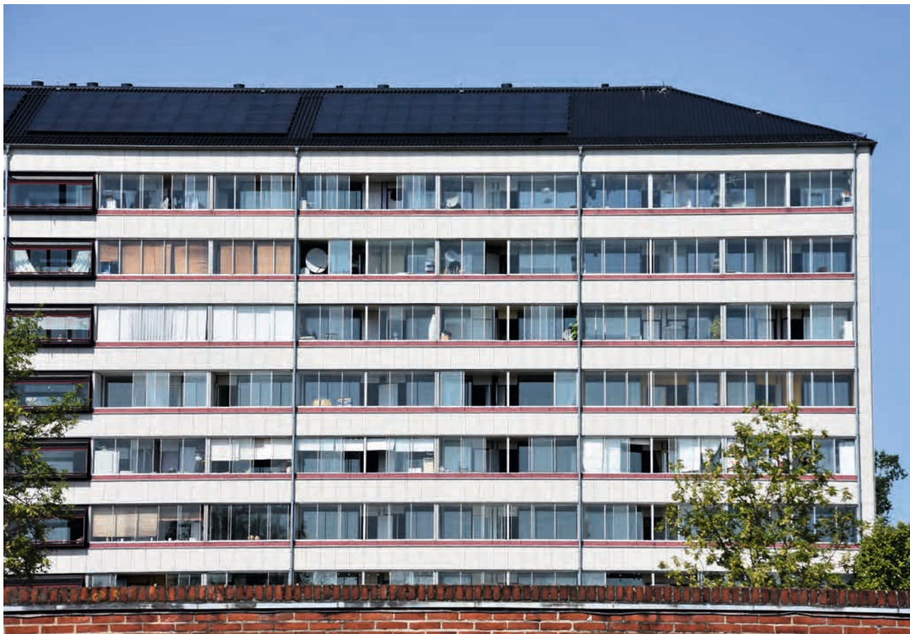
FIGUR 89. I forbindelse med renoveringen er der etableret solcelleanlæg på boligblokkenes sydvendte tagflader. Anlægget har en overproduktion på ca. 70 % om sommeren, hvilket dog ikke er en helt så god forretning som planlagt.
