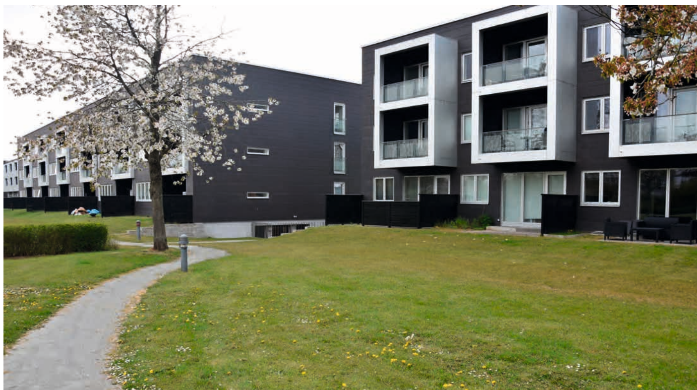
FIGUR 9. Dianavænget i Odense – nyrenoverede boligblokke.
