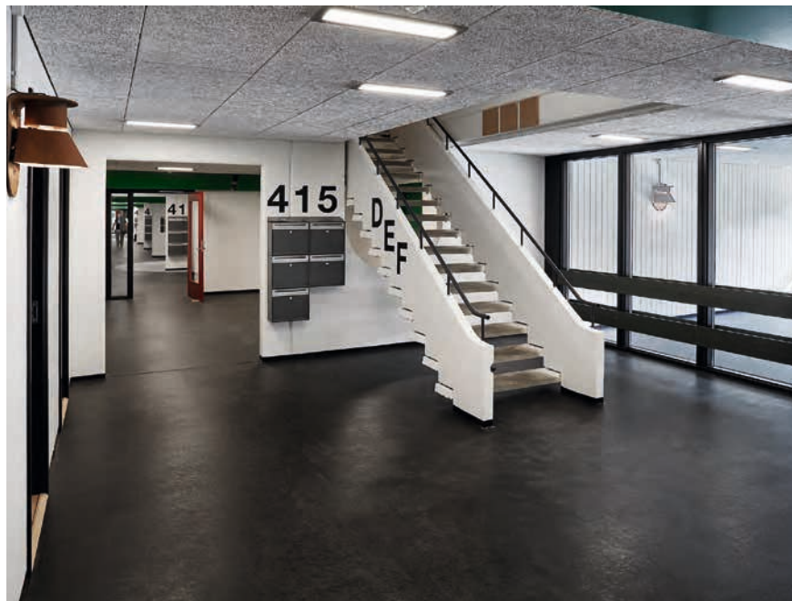
FIGUR 84. I de fælles gangarealer er den oprindelige belysning suppleret med nye armaturer i loftet, og en ny gummibelægning på gulvene er med til at forbedre akustikken. Farver, skiltning og detaljer i betonelementerne er oprindelige.
