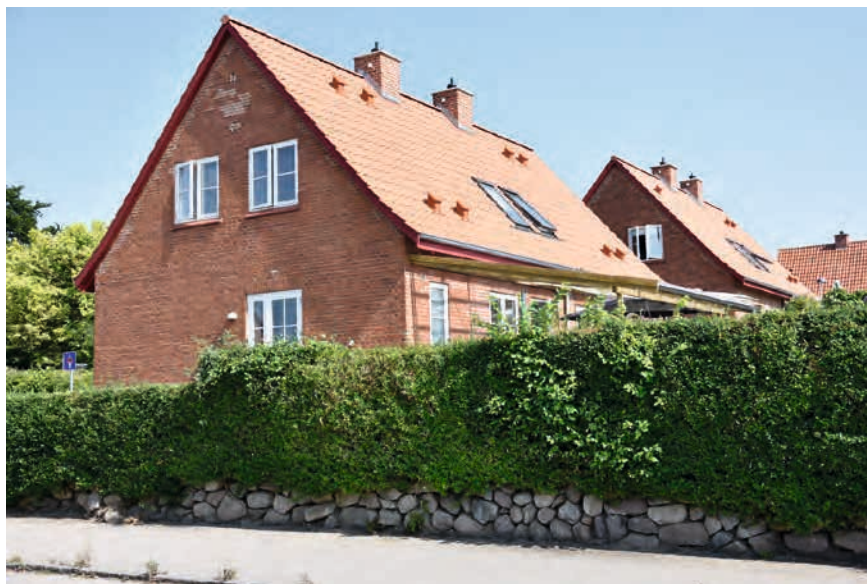
FIGUR 3. De små bygninger på Bent Grubes Vej i Holbæk har fået repareret murværkets fuger. Alligevel vurderer boligselskabet, at fuger og sokler skal repareres yderligere inden for en kort årrække.
