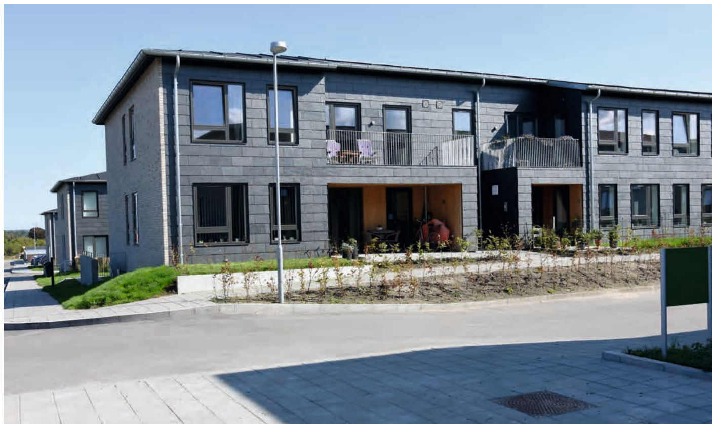
FIGUR 66. Boligblokkene har fået skalmuret gavlene, og de gavlvendte boliger har fået nye vinduer i gavlen. De øvrige facader har været revet helt ned.
