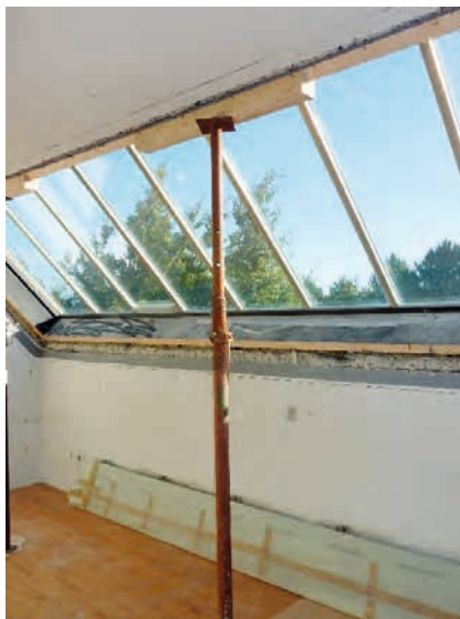
FIGUR 82. Al bygningsmateriale er skåret væk fem centimeter rundt omkring dørpartier, vægge og lofter er blevet sandblæst, og alle gulve er udskiftet. Foto: Marie Frederiksen.
