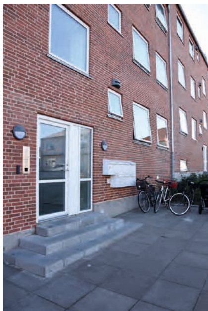
FIGUR 76. De oprindelige teaktræsdøre er blevet udskiftet med nye i træ/alu. De er muligvis mere funktionelle, men har ikke samme æstetiske kvalitet. Gadefacaderne har mistet deres markante motiver, bl.a. fordi de buede overdækninger over indgangspartierne er forsvundet.
